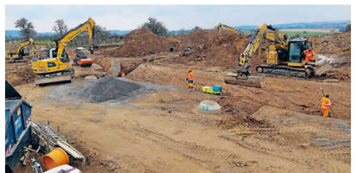
Erschließungsarbeiten der Grundstücke im Neubaugebiet Göckes in Michelbach. Die Fa. Wolff & Müller ist mit einem schlagkräftigen Team vor Ort und liegt im Zeitplan Fotos: Stadt Öhringen
