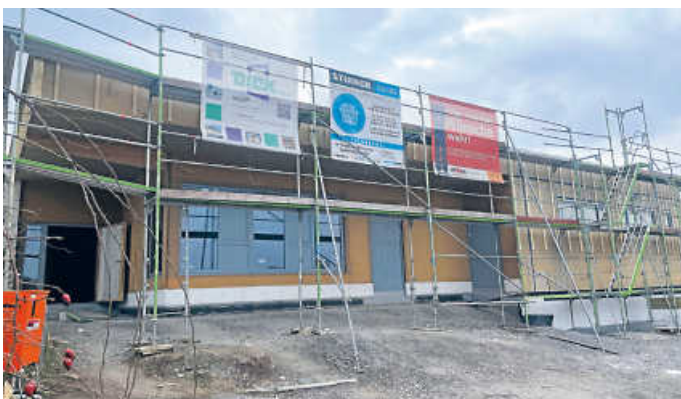
Erweiterungsbau am Kindergarten Rosenberg
